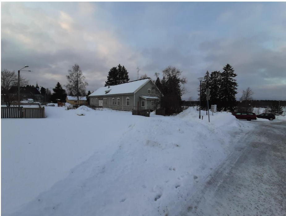
Kuva 3. Ristiinan entinen sotilasvirkatalorakennus eli "sotakoulurakennus". koillisesta päin nähtynä.
