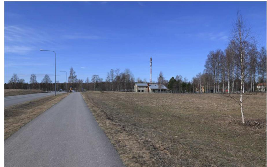
Kuva: Puustellintie rakennettiin 2000-luvun alussa virkataloon rajautuvan vanhan peltoalueen poikki uudeksi kokoojakaduksi Kissalammentien ja Saimaantien väliin. Kuvassa oikealla näkyy Mestausahon liikerakennuksia.
